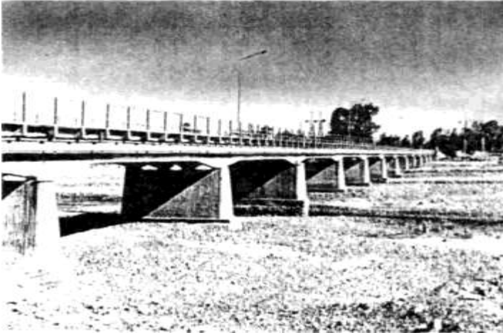
Fig. 22: Vista actual desde aguas arriba del puente del camino provincial a Barrancas, bajo el cual pasó sin producir daños el aluvión de 1934 dejando solo afectado el terraplén de acceso de la margen derecha.
