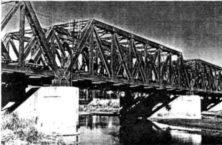
Fig. 24: Vista de un tramo completo del doble puente sustentado en pilas monolíticas únicas.
