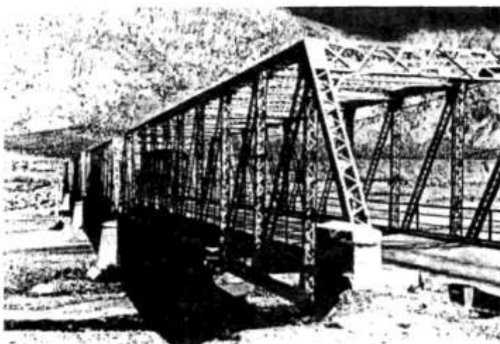
Fig. 9 y 10: Vistas desde aguas arriba y aguas abajo del puente vial de cuatro tramos metálicos sobre el río Mendoza en Uspallata, que el aluvión de 1934 no afectó.
