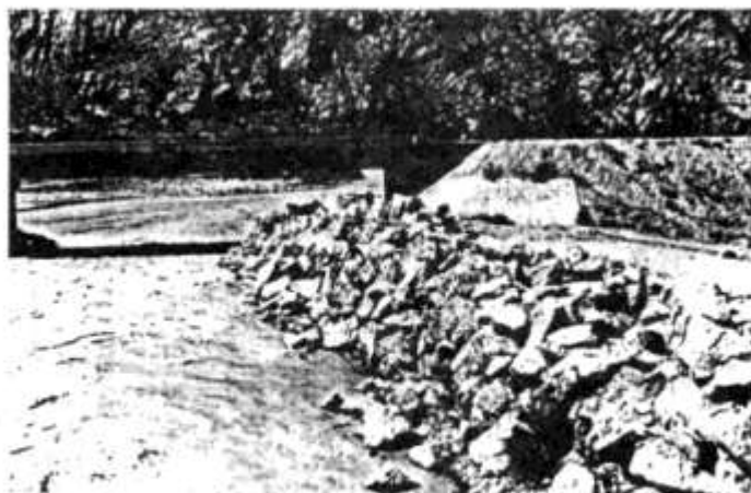
Fig. 14: Este enrocado con terraplén de apoyo se ha dispuesto entre los estribos derechos de ambos puentes, para evitar que las aguas ingresen al sector del valle de inundación entre ambos tramos de acceso.
