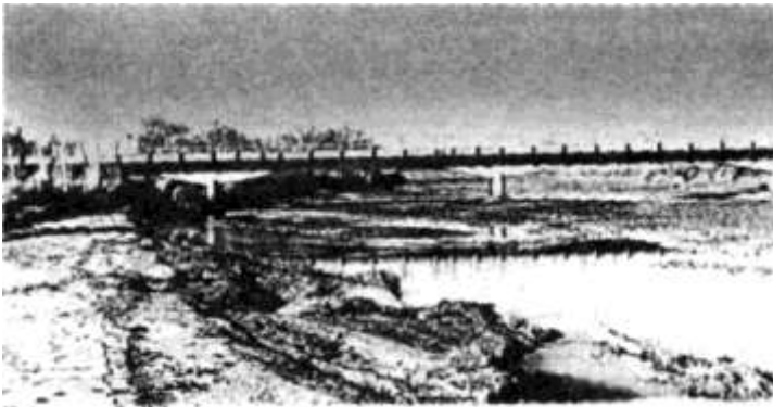
Fig. 33: Cauce actual del río en Tres Porteñas- El lecho, de reducida pendiente, muestra los sedimentos de arcilla y arena fina.
