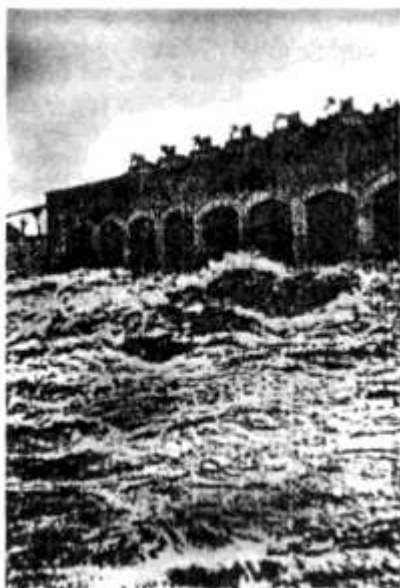
Fig. 18: Vista complementaria de la anterior en que se observa el cuerpo de compuertas de la margen izquierda dando paso a la misma crecida.
