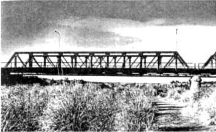
Fig. 32: Tramo extremo a partir del cual, hacia la izquierda, comienza el terraplén con que se completa el paso del río.
