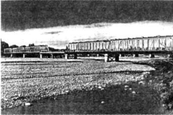
Fig. 34: Vista general del puente desde aguas arriba, hacia la margen derecha.
