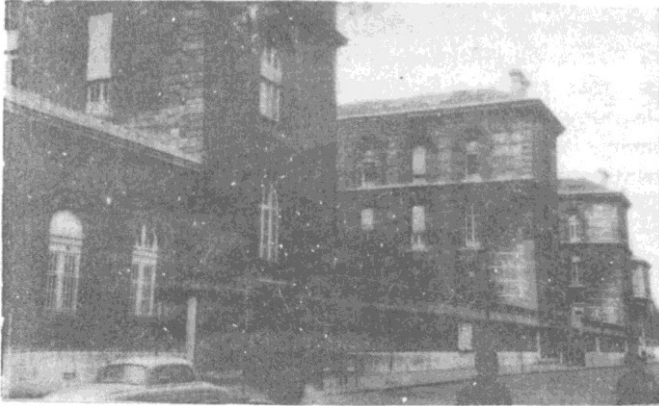
Figura 3. — Nuevo Hotel Dieu de París. Terminado de construir al final de la guerra franco-prusiana-1870. Estado actual de la fachada de los pabellones sobre la Rué D'arcole.
