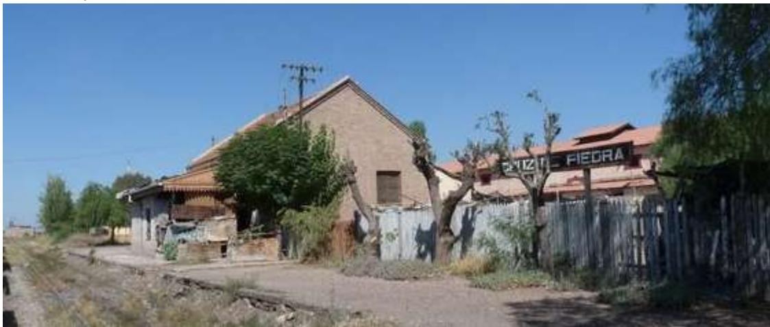
Fig. 12 Foto actual de la estación de tren de Cruz de Piedra
