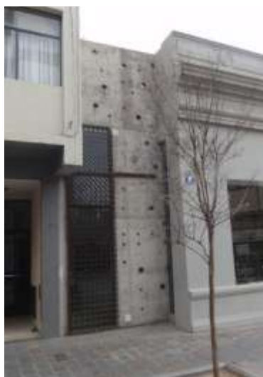
Refuerzos y conexión Galería Cerrito
