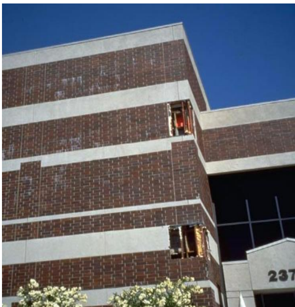
Fig. 1-12. Edificio bajo inspección para observar los daños causados por el terremoto en las conexiones viga-columna ( Earthquake Engineering Research Institute, Slides on the January 17, 1994, Northridge Earthquake, Set I: An Overview ).
