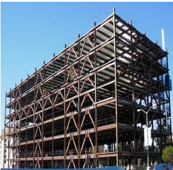
Fig. 3-6. Vista de un edificio en construcción con pórticos arriostrados.
