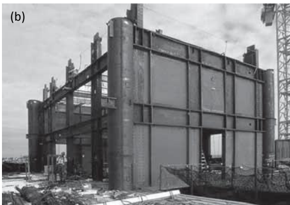
Fig. 8-1. Edificio U.S. Federal Courthouse, Seattle, que incorpora muros de corte con placas de acero, (a) vista general y (b) construcción de los muros (Sabelli y Bruneau, 2006).
