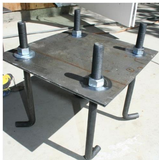
Fig. 3-63. Barras de anclaje previo a su colocación en las fundaciones.
