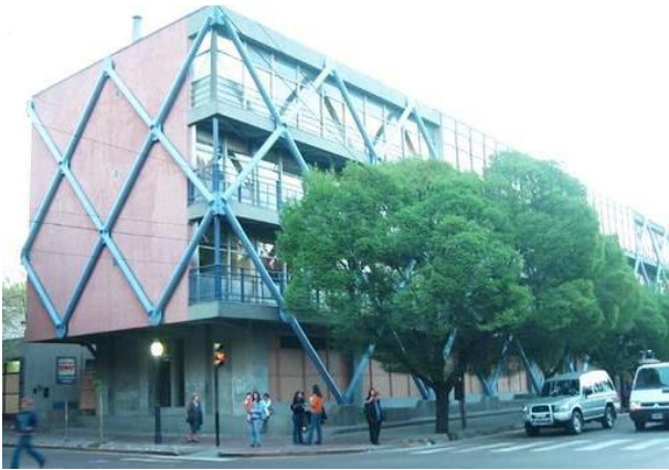
Fig. 5-37. Edificio escolar en la ciudad de Mendoza, Argentina, con estructura de hormigón armado, rehabilitado con el agregado de riostras de acero.
