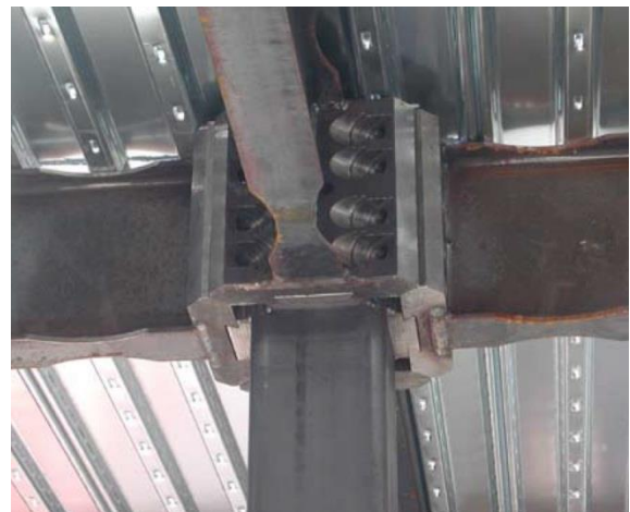
Fig. 4-22. Conexión "ConXtech ConXL" (AISC, 2010c).
