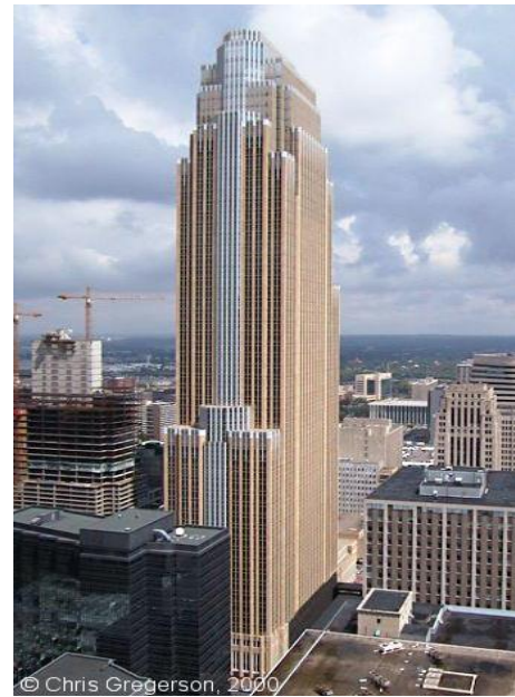
Fig. 3-40. Edificio Norwest Center (ahora Wells Fargo Center), Minneapolis, con super-columnas compuestas.
