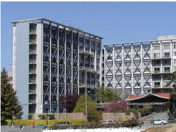
Fig. 5-38. Edificio Residence Hall, Berkely, Estados Unidos, rehabilitado con riostras de acero.
