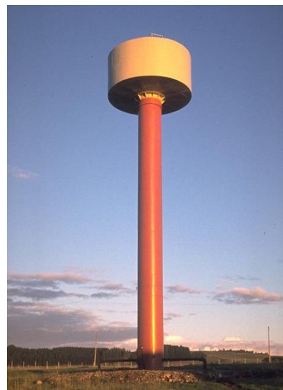
Fig. 3-18. Ejemplos del sistema estructural columnas en voladizo.
