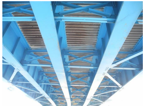
Fig. 3-54. Vista inferior de un puente carretero con arriostramientos torsionales.
