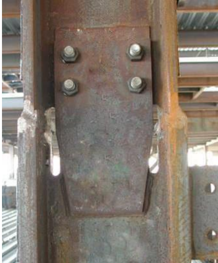
Fig. 3-57. Empalme en columna con cambio de sección.
