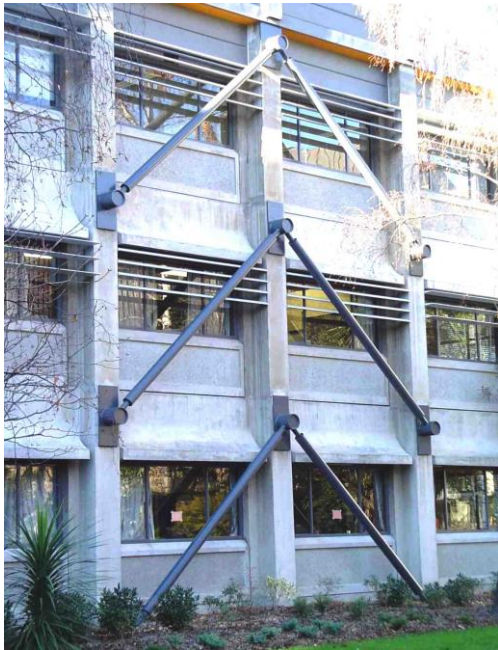
Fig. 3-12. Ejemplo de rehabilitación mediante el agregado de riostras de acero a una estructura de hormigón armado.
