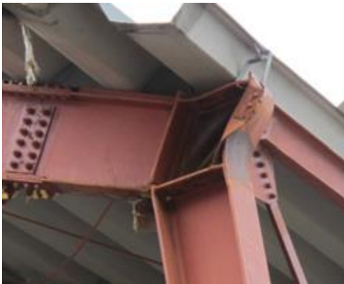
Fig. 4-8. Deformación del panel nodal por acción del sismo (Midorikawa et al., 2012).
