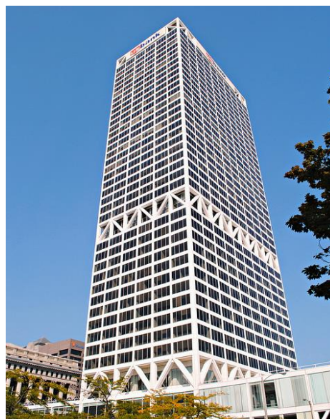
Fig. 3-33. Vista del edificio First Wisconsin Center , en Milwaukee, USA.
