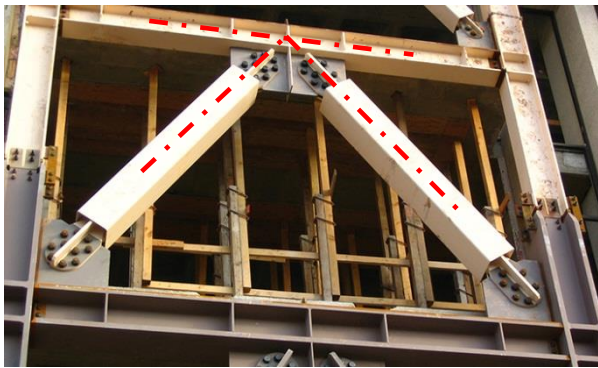
Fig. 7-1. Ejemplo de un pórtico con riostras de pandeo restringido donde se observa que la conexión es concéntrica.
