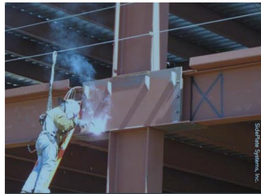
Fig. 3-19. Conexión con placas laterales.
