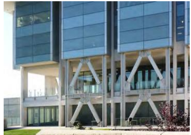
Fig. 7-16. Aplicación de riostras de pandeo restringido para la rehabilitación del edificio de la Biblioteca Marriott de la Universidad de Utah.
