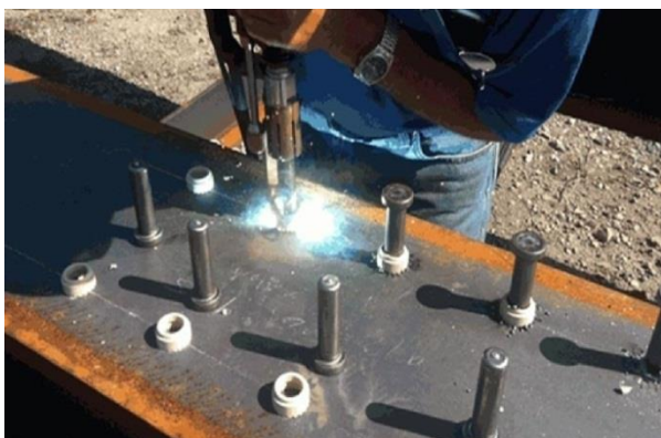
Fig. 1-24. Colocación de pernos soldados sobre el ala de una viga de acero.
