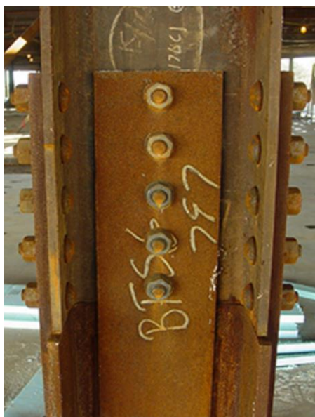
Fig. 3-55. Empalme en columna con cambio de sección.
