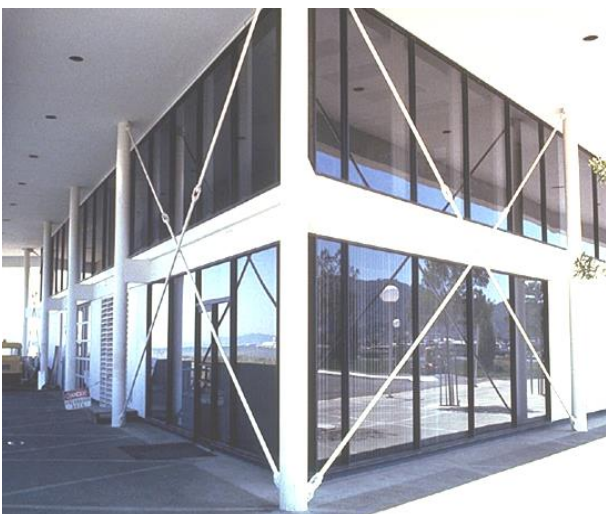
Fig. 5-19. Pórtico arriostrado con tensores en X.
