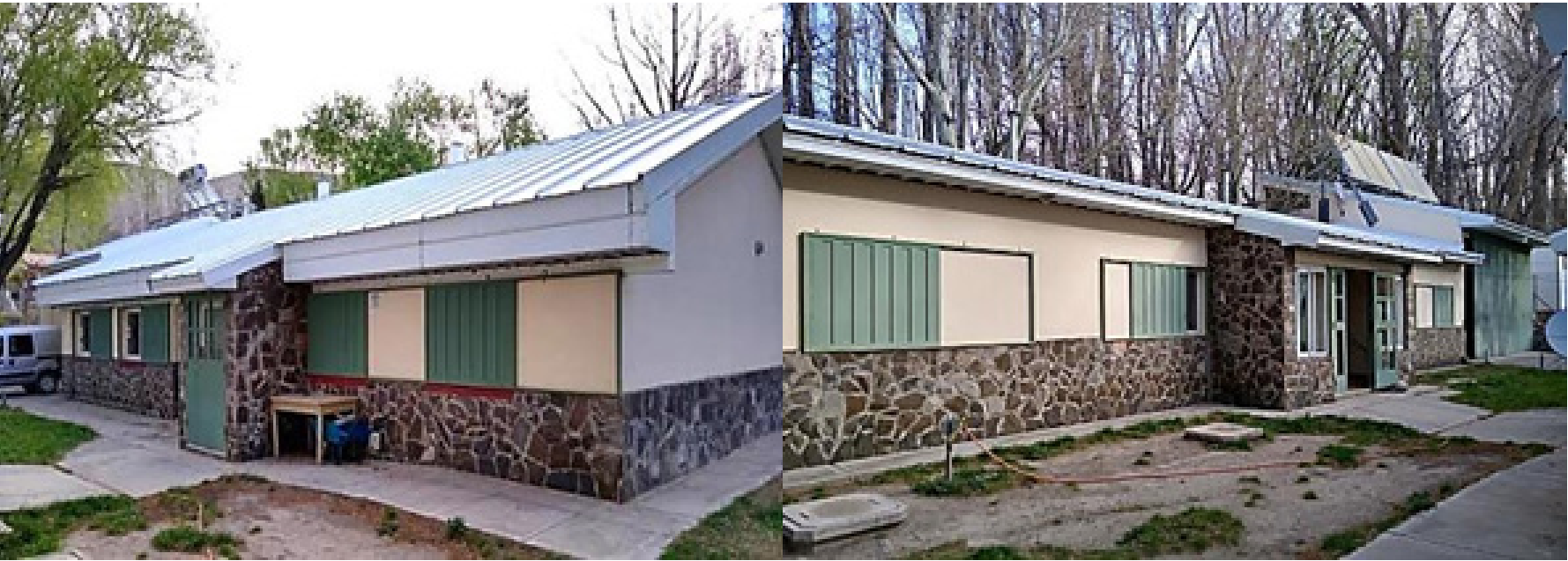
Figura 1: (izq.) Foto del Centro de Salud luego del reciclaje. (der.) vista N del departamento del Chofer y la Enfermera con los sistemas de calentamiento de agua solar.
